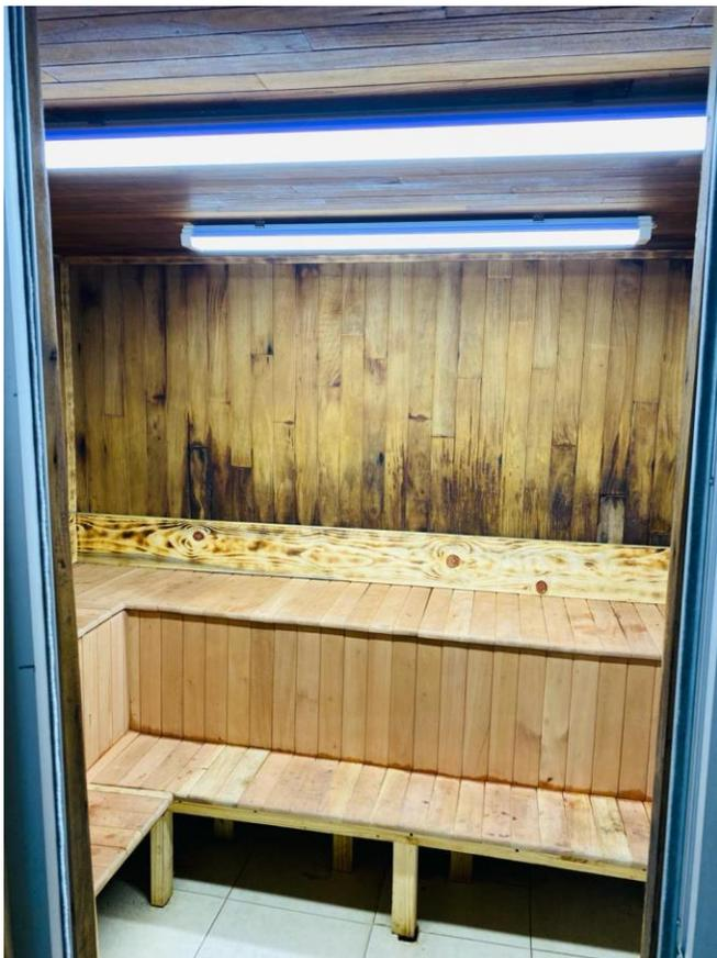
*Se realizó el mantenimiento del área del **Sauna de Caballeros**, se reemplazó la mayor parte de la madera dañada y corroída, se mejoró la iluminación, se restauró el calefactor, se restauraron las resistencias, se instaló un nuevo termostato de bulbo y se cambió la puerta de aluminio.*
